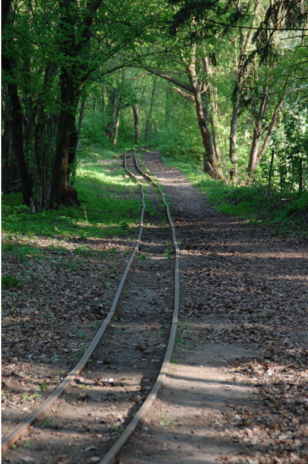
Der Gleiszustand im Wald in der Nähe der Brunsenkoppel
