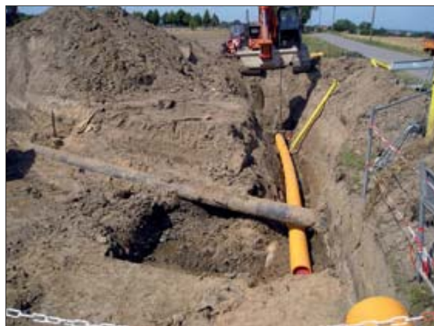
Ersetzen eines NW-300-Stahlrohres durch ein Polyethylen-Rohr bei Glas-hagen
