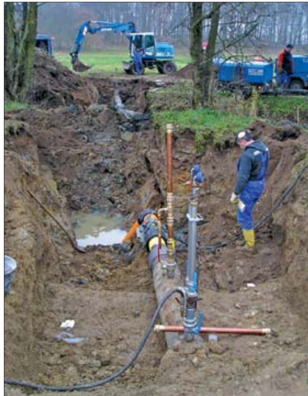
Arbeiten bei der Setzung des Dükkers in Detershagen, westlich Kröpelins
