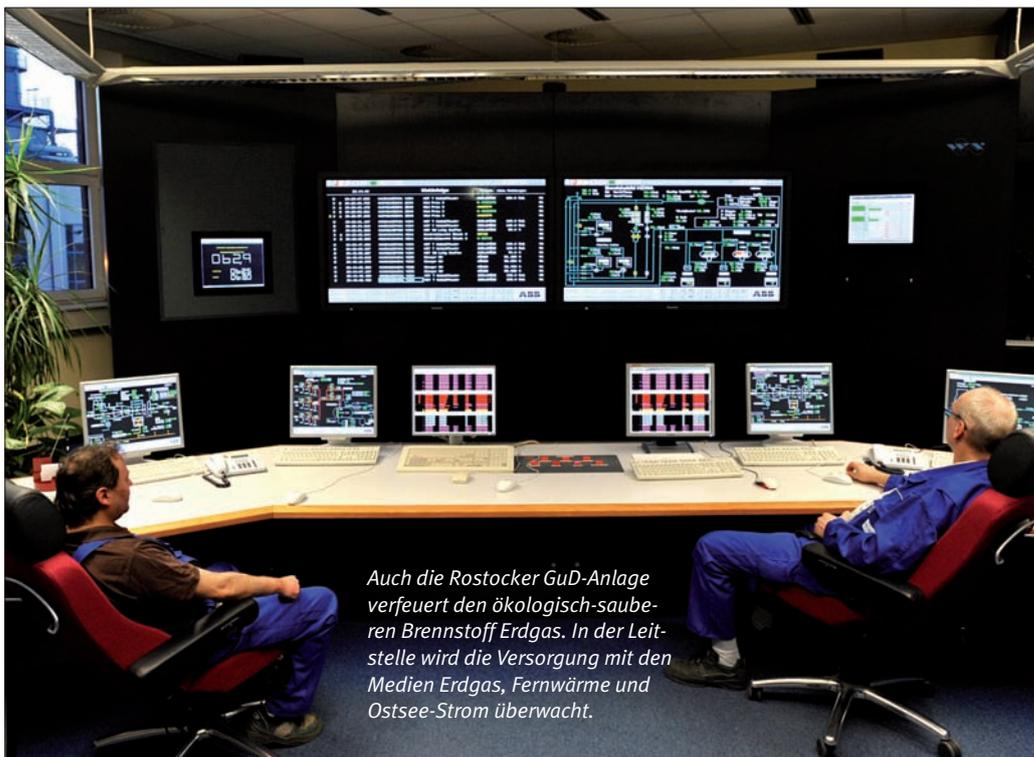
*Auch die Rostocker GuD-Anlage verfeuert den ökologisch-sauberen Brennstoff Erdgas. In der Leitstelle wird die Versorgung mit den Medien Erdgas, Fernwärme und Ostsee-Strom überwacht.*
