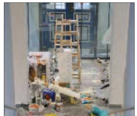
Letzte Arbeiten vor der Neueröffnung des HdS
