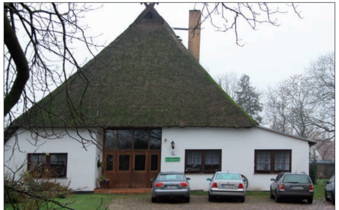
Modernisiertes Bauernhaus in Sievershagen
