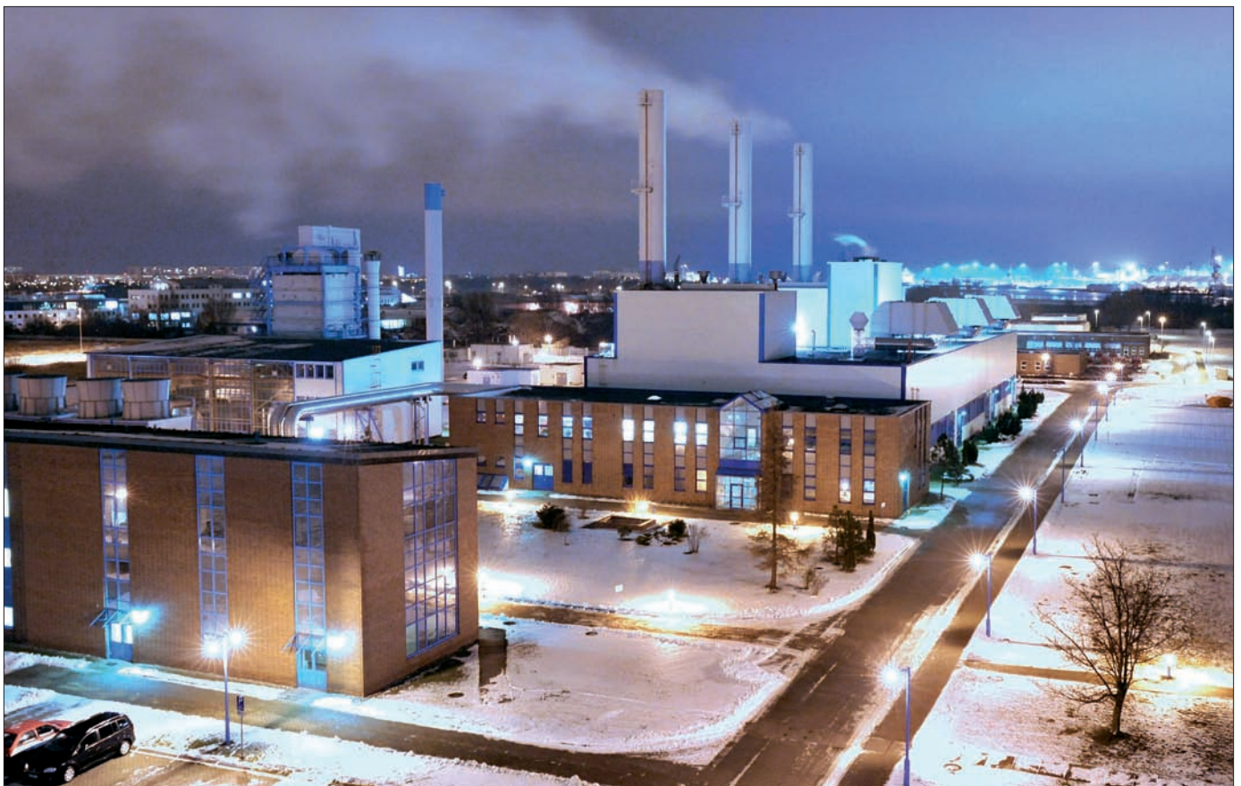
Die GuD-Anlage der Stadtwerke Rostock AG – umweltschonende Energieerzeugung in Kraft-Wärme-Kopplung.
