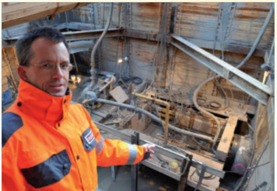
*Verlegung eines Fernwärmedükers für die Fernwärmeauskopplung zum Steinkohlekraftwerk, der für die Versorgung der Stadt und des Seehafens von besonderer Bedeutung ist und der die BAB 19 unterquert. STRABAG Bauleiter Jens Große an der 10 m tiefen Baugrube.*
