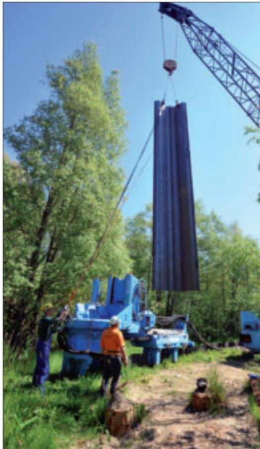
Eine Dichtwand unter Einbeziehung der vorhandenen Doppelspundwand soll das gesamte historische Gaswerksgrundstück sichern. Die ca. 1.000 m lange Dichtwand wird einen weiteren Schadstoffaustrag dauerhaft verhindern, eine Horizontalfilterbrunnenanlage, eine Grundwasserreinigungsanlage, eine teilweise Oberflächenabdichtung sowie ein Stauraumkanal werden entstehen. Die Bauzeit für das Sanierungsvorhaben beläuft sich auf ca. zwei Jahre. 5,7 Mio. Euro wird die Maßnahme kosten.
