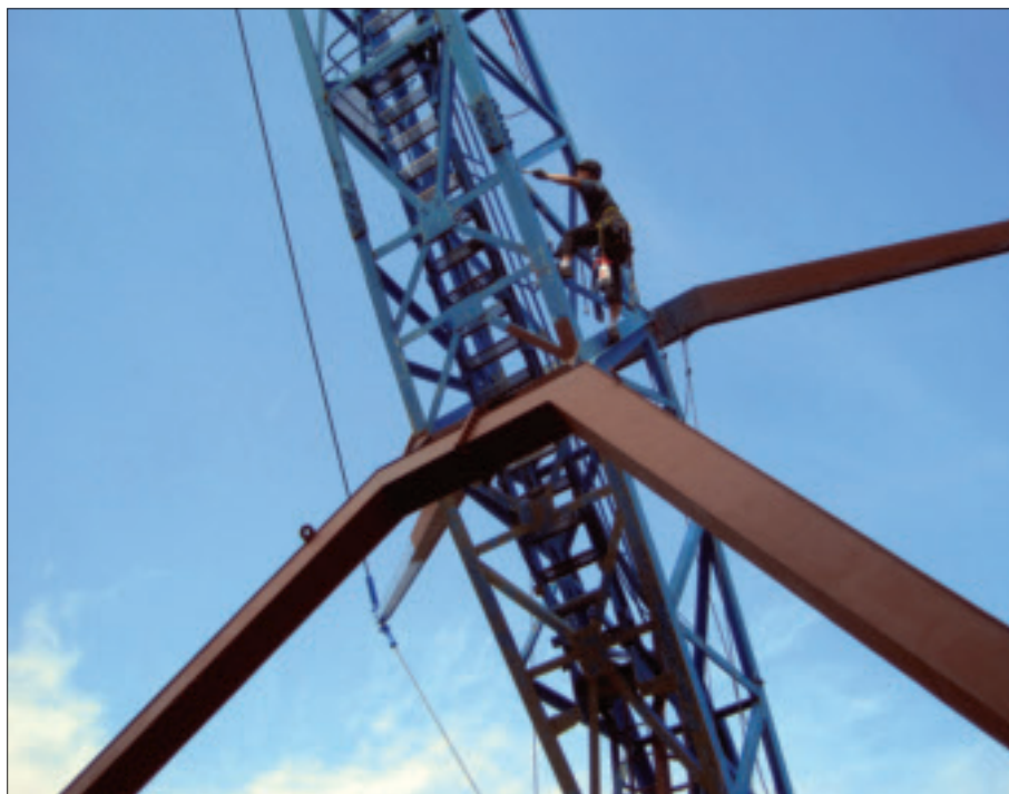
Arbeiten an den Flutlichtmasten des Ostseestadions.
