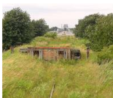
Das Gleisende bei Bresewitz vor der Meiningenbrücke Im August 2004 Fotos : L. Schultz
